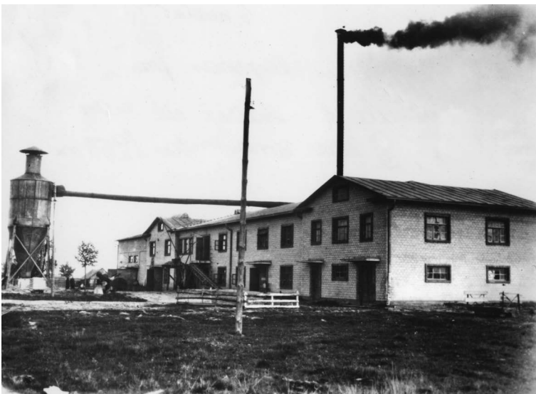
Pagrindinis korpusas prieš rekonstrukciją. Kairėje matyti ciklonas (dulkių gaudytuvas), išmontuotas 1958 m.
